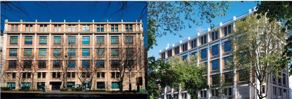
Ancienne centrale téléphonique du début du XX e réhabilitée par Covivio Crédit photo : DR / Olivier Quaslet
