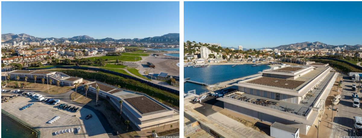
Le stade nautique Roucas blanc de Marseille et ses 5 terrasses végétalisés
