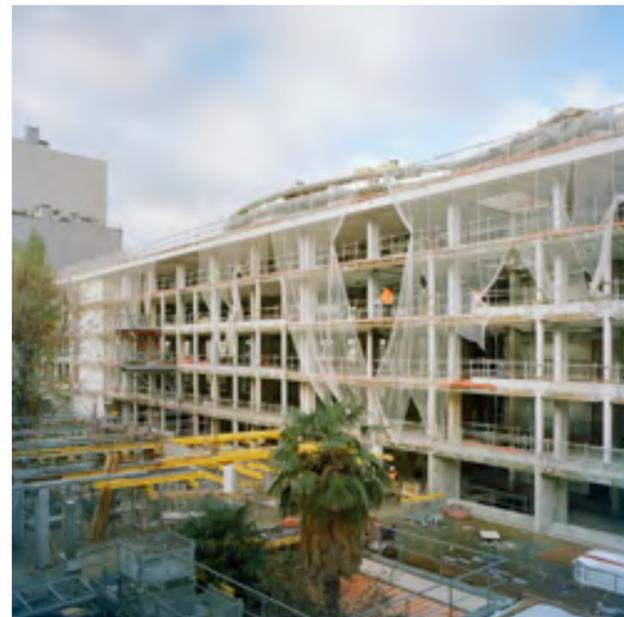
Ces deux bâtiments neufs et la surélévation du bâtiment B ont été réalisés avec une structure mixte bois-béton, plus légère qu'une structure béton, afin d'éviter le renforcement des fondations, et privilégier les matériaux biosourcés.
