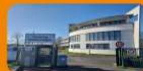
Chantier URSSAF Orvault
