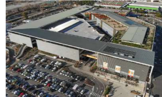
CARREFOUR Nice (06) Marché de travaux 983 places créées
