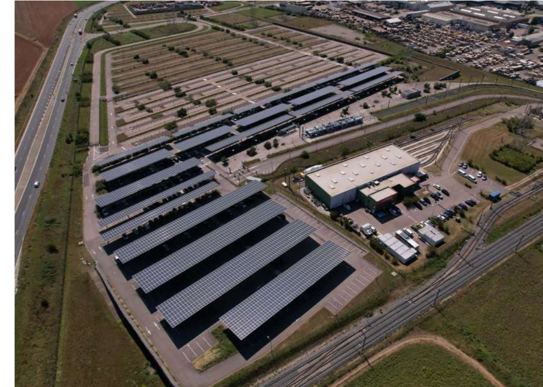
EDF ENR Parking Relais Meyzieu les Panettes (69) Marché de travaux 1,9 MWc - 674 places couvertes
