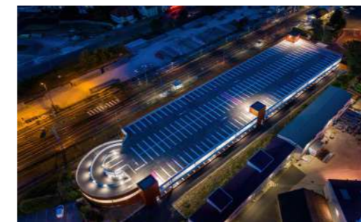
EFFIA Gare SNCF de Nangis (77) Marché de travaux 499 places créées
