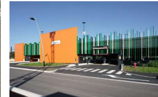
EFFIA Gare SNCF de Moret Veneux les Sablons (77) Marché de travaux 630 places créées
