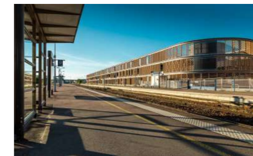
EFFIA Gare SNCF de Troyes (10) Marché de travaux 395 places créées
