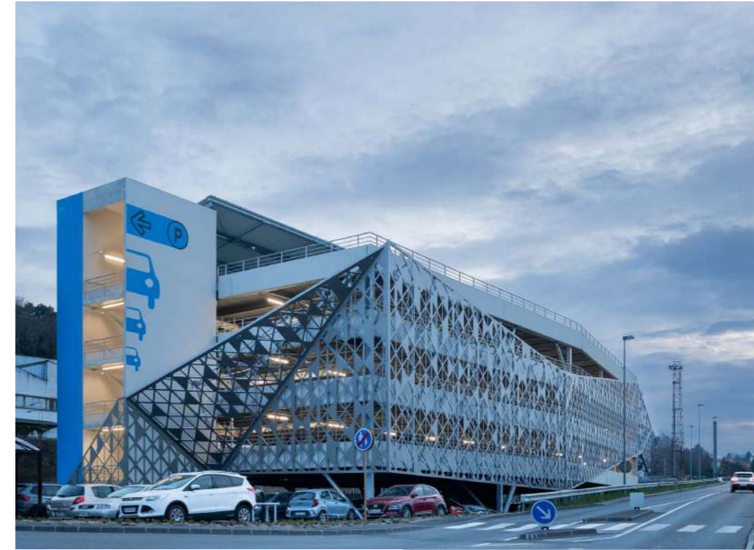
VILLE D'EVIAN Gare SNCF d'Evian (74) Conception/Réalisation 183 places créées
