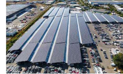
VALECO Fleury Merogis (91) Marché de travaux 9.9 MWc - 3 676 places couvertes
