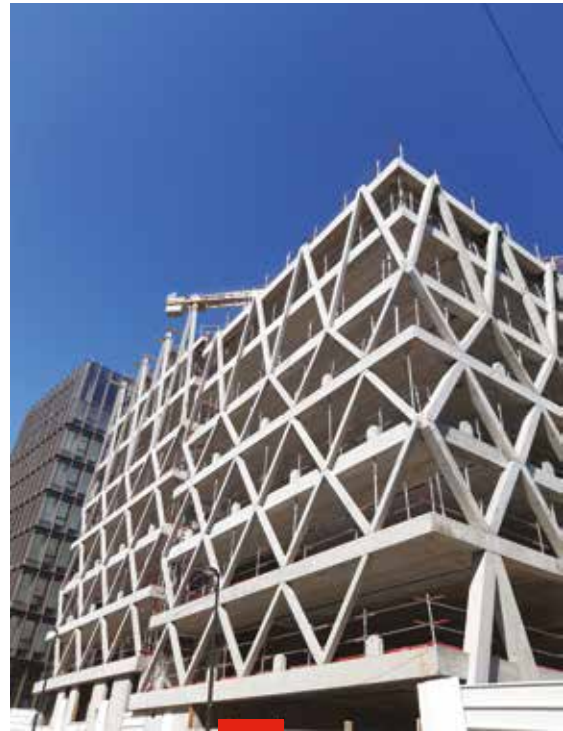
Parking silo du village des athlètes sur l'île Saint Denis pour les JO 2024.
